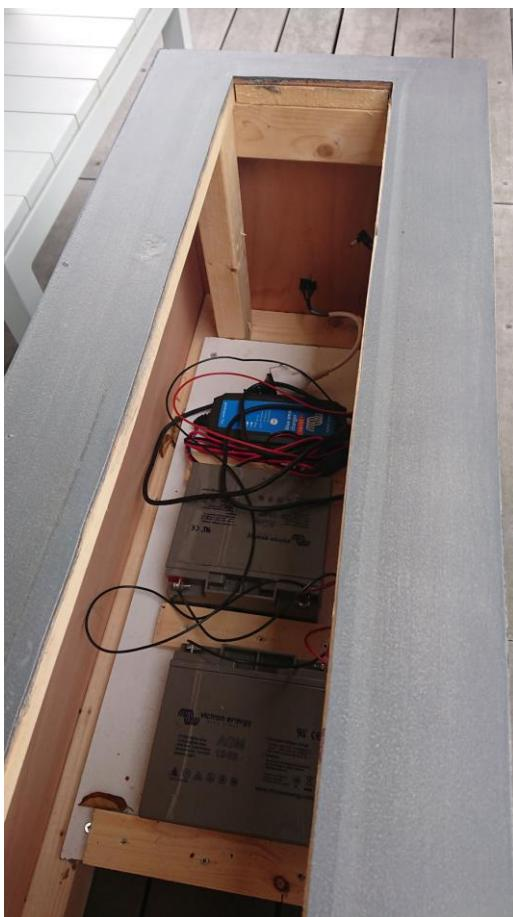
La charge peut être effectuée avec un chargeur de batterie, par exemple le chargeur [Victron Blue Smart](#). L'avantage de ce chargeur est qu'il peut être lu via une connexion Bluetooth avec votre téléphone - utile si les batteries et le chargeur sont cachés dans un endroit où il n'est pas facile à atteindre. Sur la photo de gauche, vous pouvez voir les deux batteries + chargeur cachés dans la boîte mobile.
