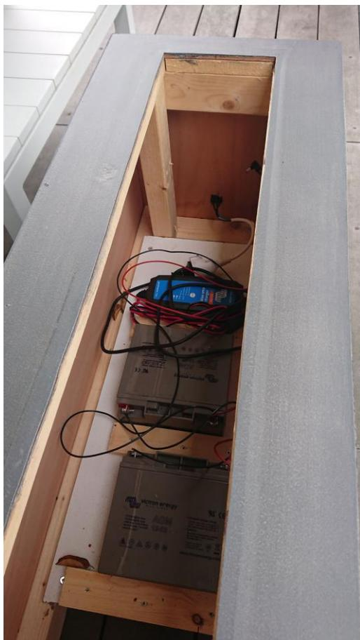
Der Ladevorgang kann mit einem Ladegerät erfolgen, beispielsweise mit dem [Victron Blue Smart](#)-Ladegerät. Der Vorteil dieses Ladegeräts besteht darin, dass es über eine Bluetooth-Verbindung mit Ihrem Telefon gelesen werden kann - praktisch, wenn die Akkus und das Ladegerät an einem Ort versteckt sind, an dem es nicht leicht zu erreichen ist. Auf dem Foto links sehen Sie beide Akkus und das Ladegerät, die in der Handybox versteckt sind.
