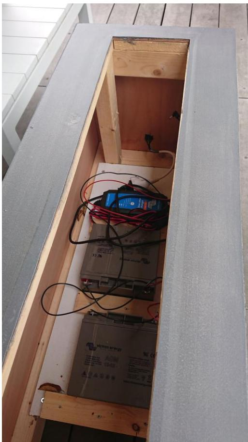
Opladen kan met een acculader, bijvoorbeeld de [Victron Blue Smart](#) lader. Het voordeel van deze lader is dat die via een bluetooth verbinding met uw telefoon is uit te lezen – handig als de accu's & lader zijn weggewerkt op een plek waar niet zo makkelijk bij te komen is. Op de foto links ziet u beide accu's + oplader in de verrijdbare bak weggewerkt.
