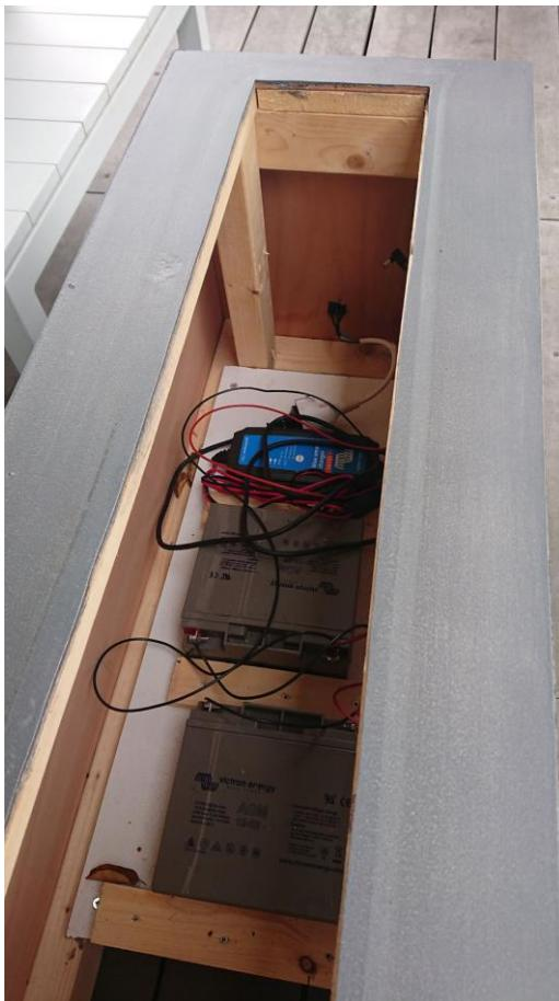
La carga se puede realizar con un cargador de batería, por ejemplo, el cargador [Victron Blue Smart](#). La ventaja de este cargador es que se puede leer a través de una conexión bluetooth con su teléfono, lo que es útil si las baterías y el cargador están escondidos en un lugar donde no sea fácil de alcanzar. En la foto de la izquierda se pueden ver ambas baterías + cargador oculto en la caja del móvil.
